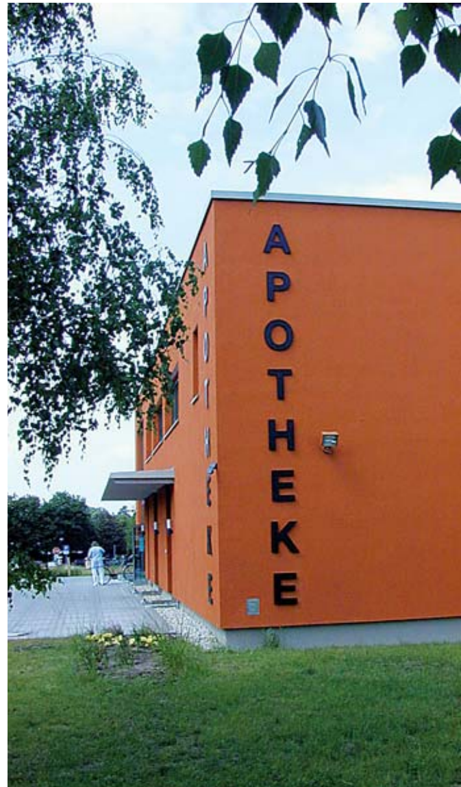
Das neue Apothekengebäude
